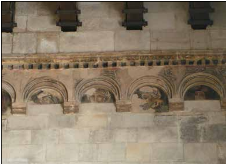
Fig. 16 Bisceglie, cattedrale, navata centrale: decorazione pittorica della cornice superiore (foto L. Acquaviva)
